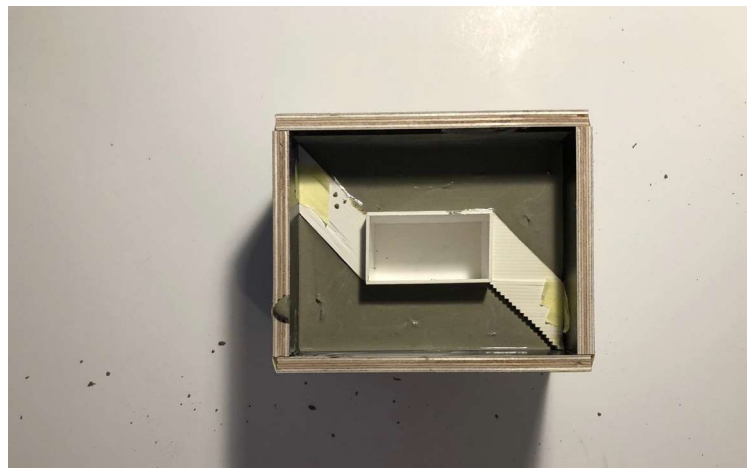
Zum Schluss mit Beton ausgießen.
