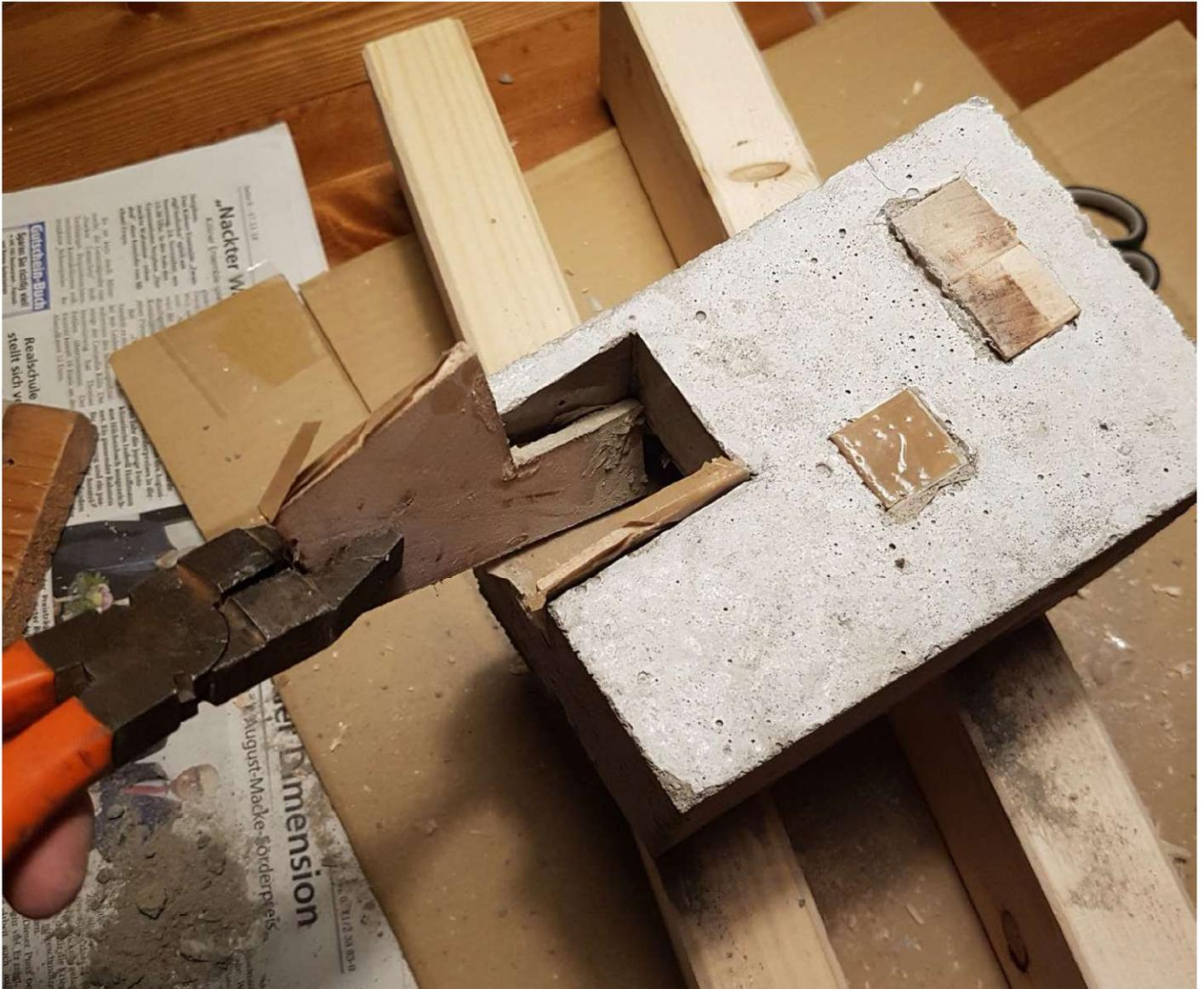
...und dann mit Hilfe von Zange, Hammer, Meißel und Bohrer die innere Schalung entfernt.
